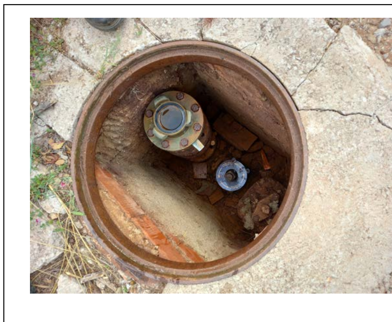
Fig 3: Hidrant soterrada
